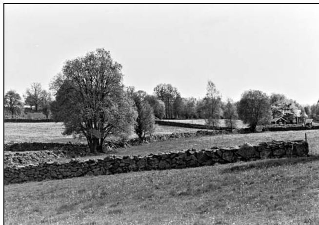
Vällagda, kallmurade stenmurar markerar ägogränserna i Sötåsa by, Gällaryd
