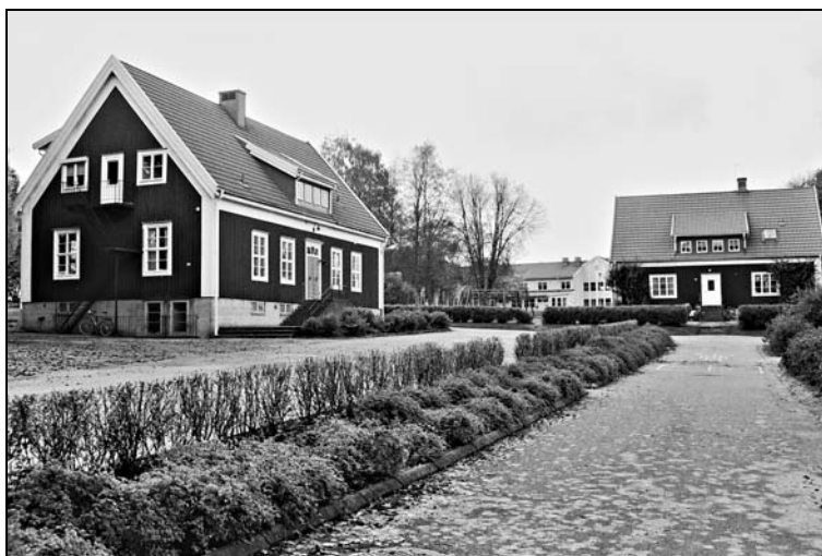
Skolbyggnad och f d lärarbostad från 1928 (Bredaryd 44:1)
