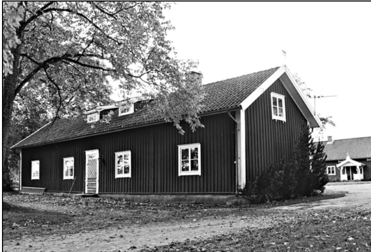
Östra flygelbyggnaden på Annebergs herrgård (Anneberg 1:11)
