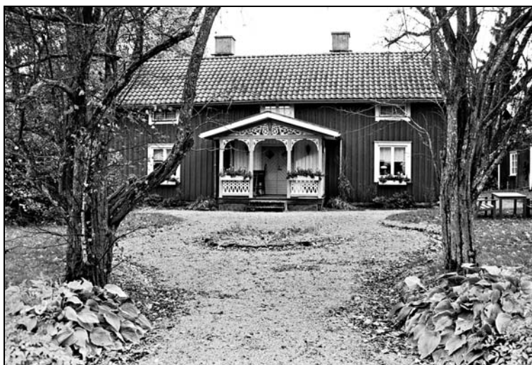
Manbyggnaden på Hamra 7:1 (Lunnagård), en knuttimrad parstuga
