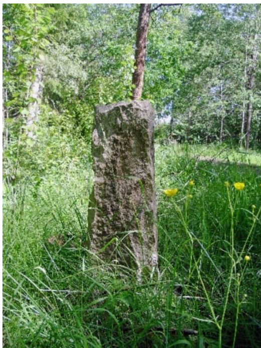
Stenfundament, väster om träbron.
