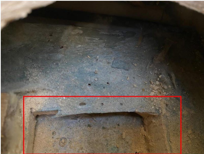
Foto 9, provbit tagen på salningsträ i golvkonstruktion
