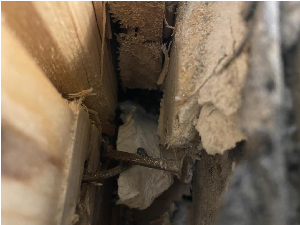
Foto 12, missfärgat skivmaterial, PPG/V8
