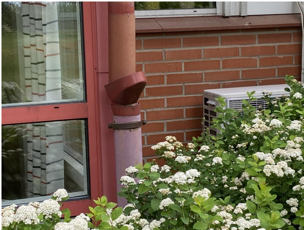
Foto 3, renssilar, sitter fel på flera plaster.
