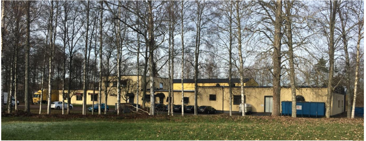
Industribyggnad på fastigheten Aftonfalken 1. Bilden är tagen från cykelvägen nordöst om fastigheten.
