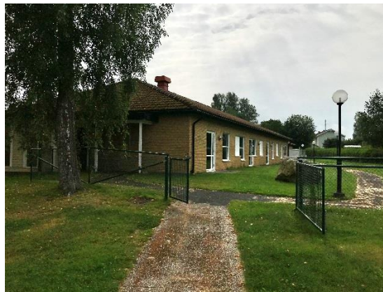
Befintlig byggnad som eventuellt ska bevaras
