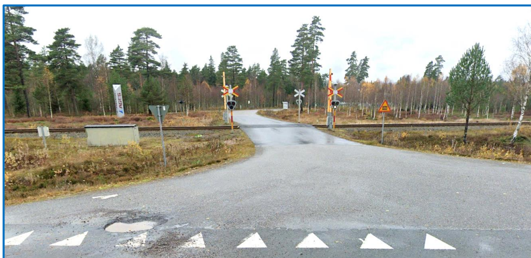
Bild 3. Befintlig plankorsning mellan järnvägen och väg mot Ages Hörle AB är försedd med järnvägsbommar.
