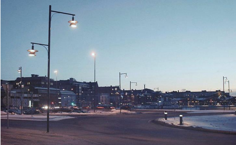
Figur 36. Inspirationsbild, belysningsstolpar med kombinerat montage för både gata och gång- och cykelstråk.
