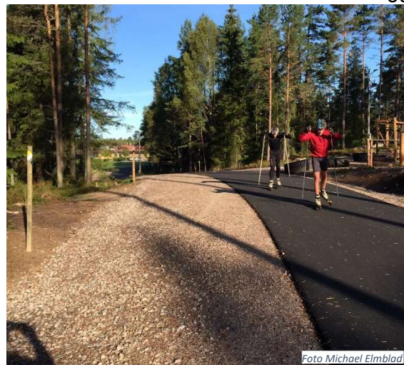
Asfaltering öppnar nya möjligheter.
