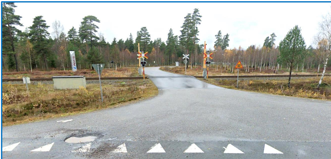
Bild 3. Befintlig plankorsning mellan järnvägen och väg mot Ages Hörle AB är försedd med järnvägsbommar.
