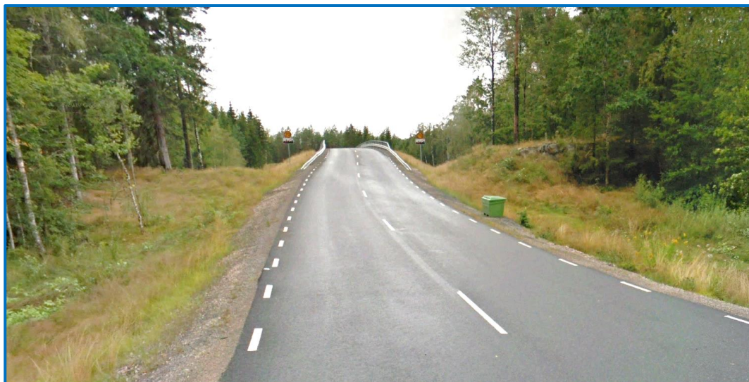
Bild 14. Befintlig enskild väg norr om Hörle Wire AB som korsar järnvägen planskilt.
