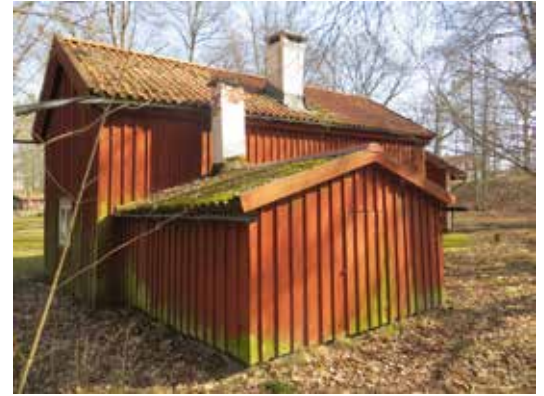
Krukmakeriets baksida har en utbyggnad som inrymmer brännugnen.
