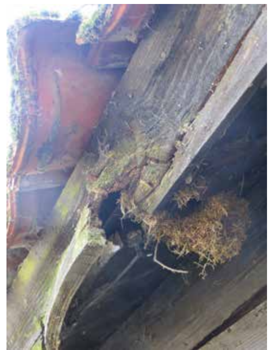
Ovan: Rötskador i takfallet nedanför skorstenen. Till vänster: En del äldre verkstadsutrustning finns bevarad inne i tråddrageriet.
