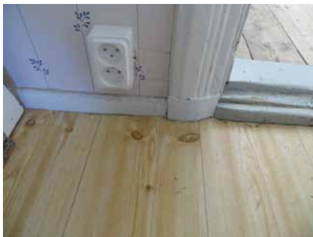
Det sydöstra rummet i prästgårdsbyggnaden.
