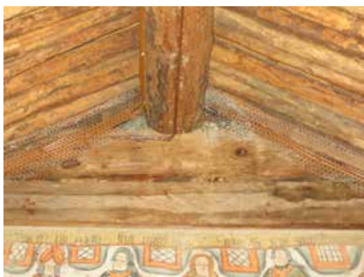
Detaljbild av takets konstruktion. Vid övergången mellan timmerväggen och taket finns hönsnät.
