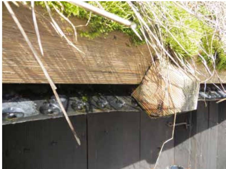
Torvtaket ligger på en platonmatta som är väl synlig vid takfoten.
