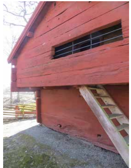
Ovan: Loftbodens gavel med trappan upp till vinden. Till vänster: Loftbodens framsida.
