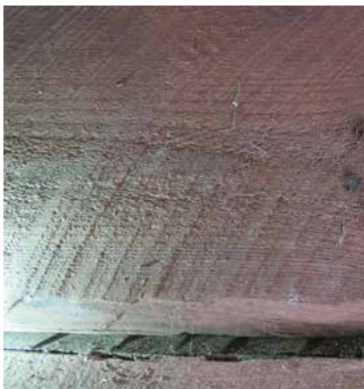
Ovan: Linbastans två eldstäder. Foto före 2018. Nedan: På insidan av innerväggarna finns spår efter att stockarnas insida sågats med cirkelsåg.
