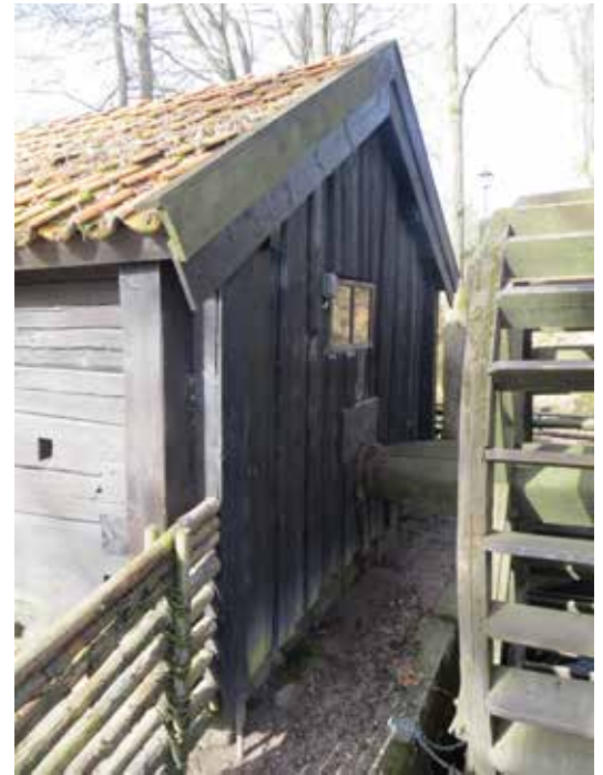
Vattenhjulets anslutning mot tråddrageriet.
