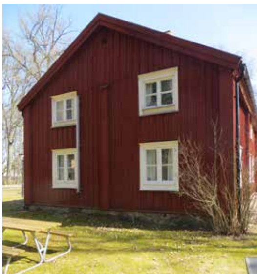
En av gavlarna har ett fönster som modifierats så att man kan evakuera övervåningen via en utfällbar stege.
