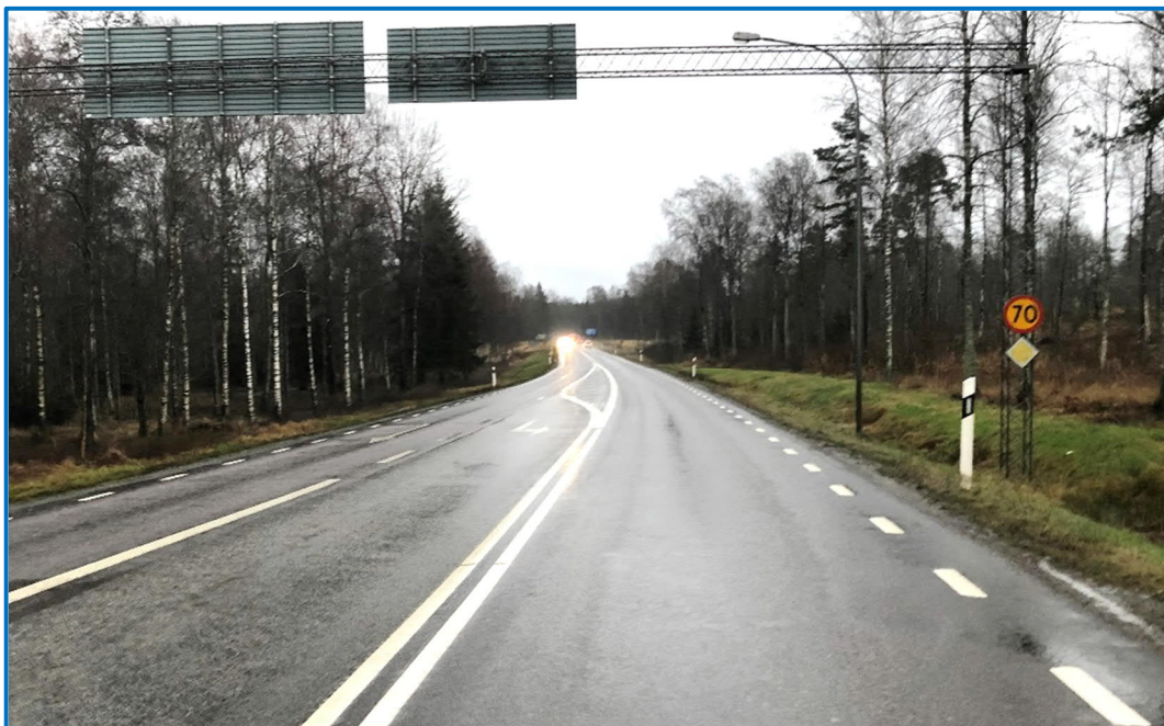
Bild 4. Väg 27 är i anslutning till korsningen med Storgatan utbyggt med ett vänstersvängfält.
