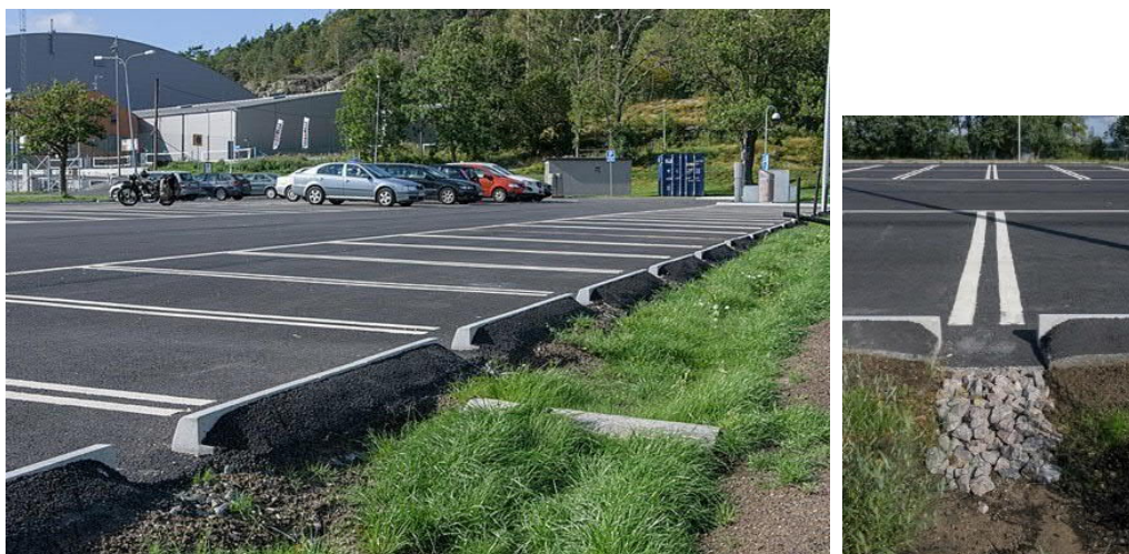
Figur 12. Exempel på utformning av översilningsyta. Notera erosionsskyddet i lilla bilden. Foto: SMHI, Peter Svensson.
