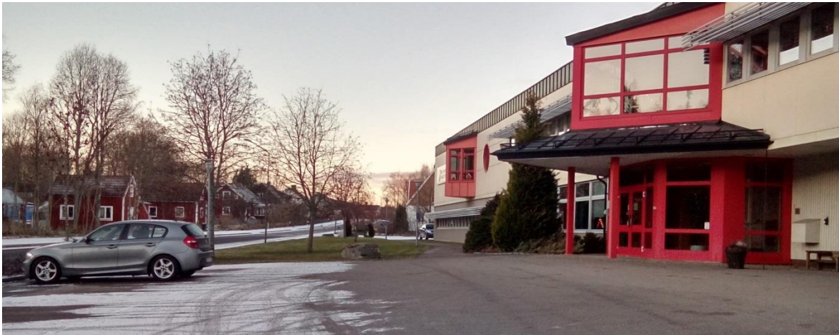
Figur 7. Vy tagen norrut, befintlig bebyggelse till höger i bild med tillhörande parkering som berörs av detaljplaneförslaget. Till vänster i bild syns Alvestavägen och befintlig bostadsbebyggelse som angränsar till planområdet.
