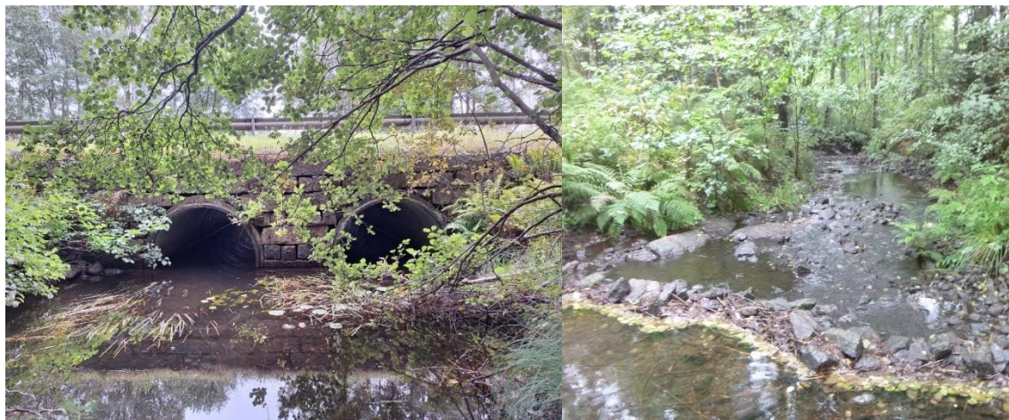
Figur 8-5. Foton av Lillån. Lugnflytande parti nedströms vägtrummor vid Hindsens norra utlopp (vänster foto). Längre nedströms med nackar och höljer och en anlagd nacke i förgrunden som utgör bestämmandesektion (höger foto). Foton från 2025-10-02.
