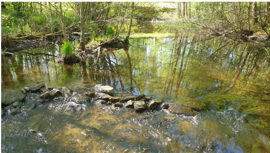
Figur 8-6. Hindsens norra utlopp till Lillån med uppbyggd stentröskel.
