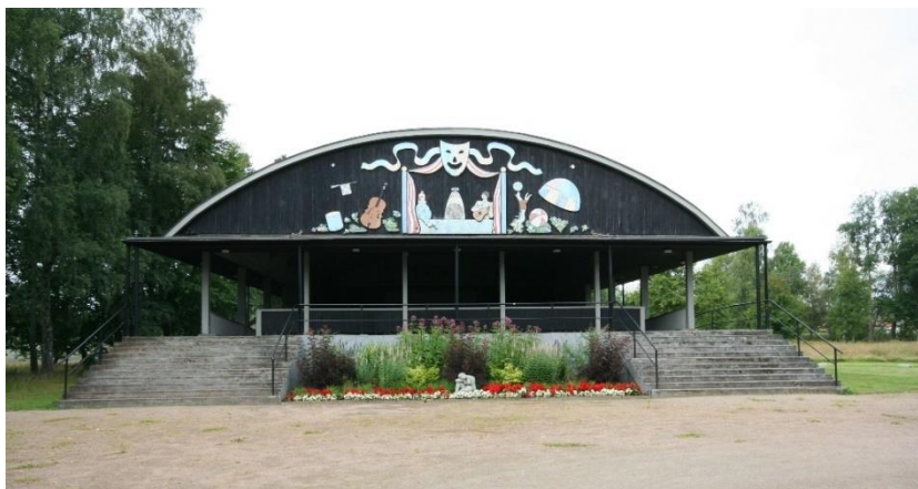
Teaterbyggnaden från entrésidan med konstreliefen i tympanonfältet. Foto: Värnamo kommun.
