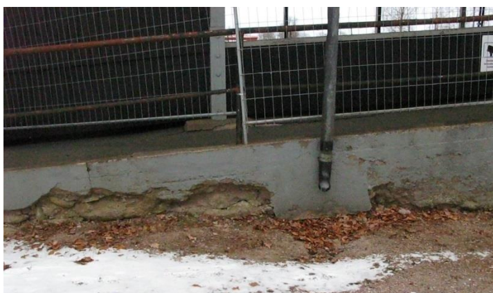
Teaterbyggnaden, skador i betongen på stensockeln.
