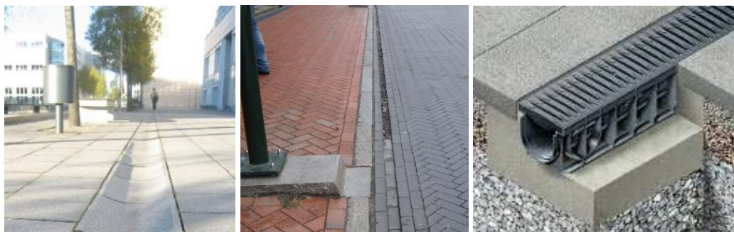
Figur 18: Exempel på öppna dagvattenrännor (Sweco, 2019).
