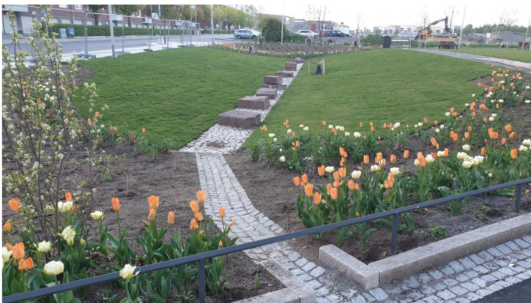
Figur 14: Exempel på torrdamm (Sweco, 2020).
