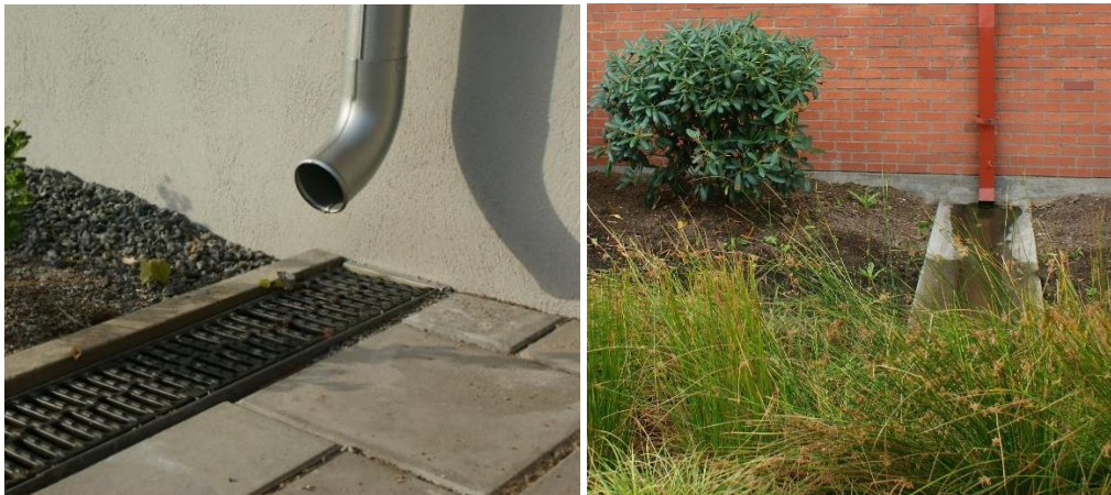
Figur 20: Dagvattenrännor för stuprörsutkastare (Sweco, 2019).
