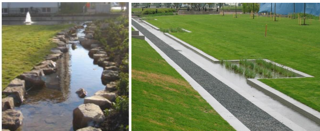
Figur 22: Öppna dagvattenkanaler (Sweco, 2019).
