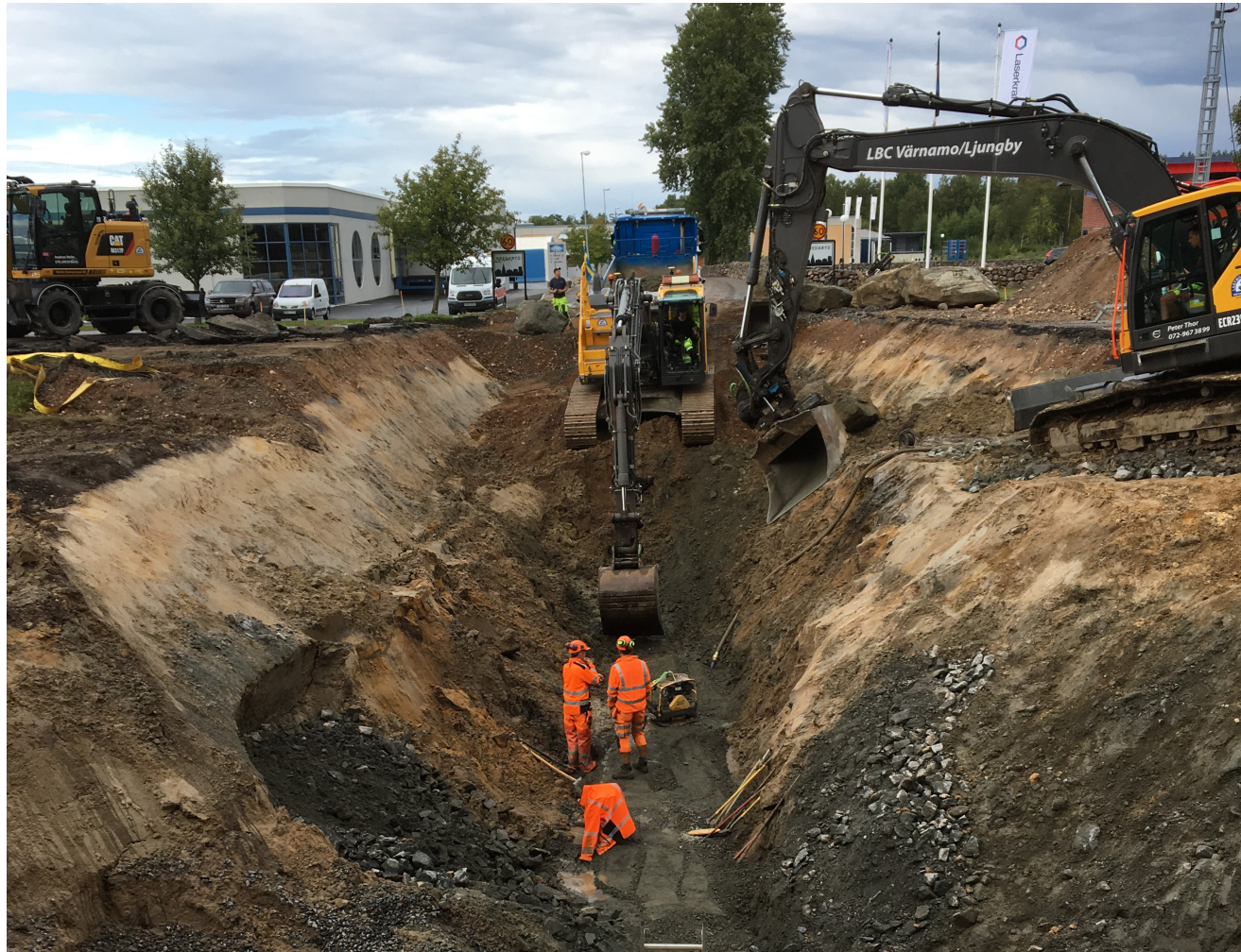
Arbete med överföringsledningar Värnamo-Bredaryd.
