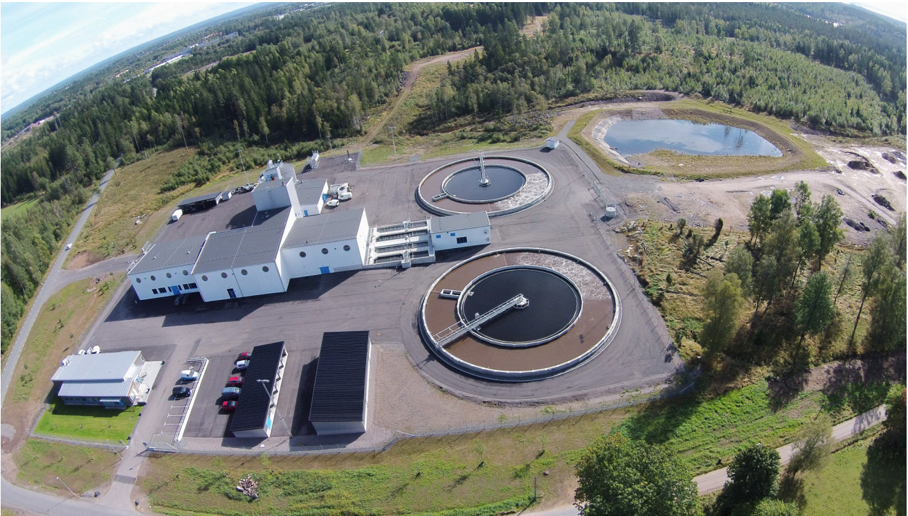
Värnamo kommuns reningsverk Pålslund.
