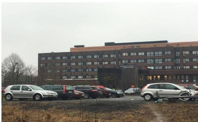
Värnamo sjukhus (södra entrén) sett från söder, bild från 2018
