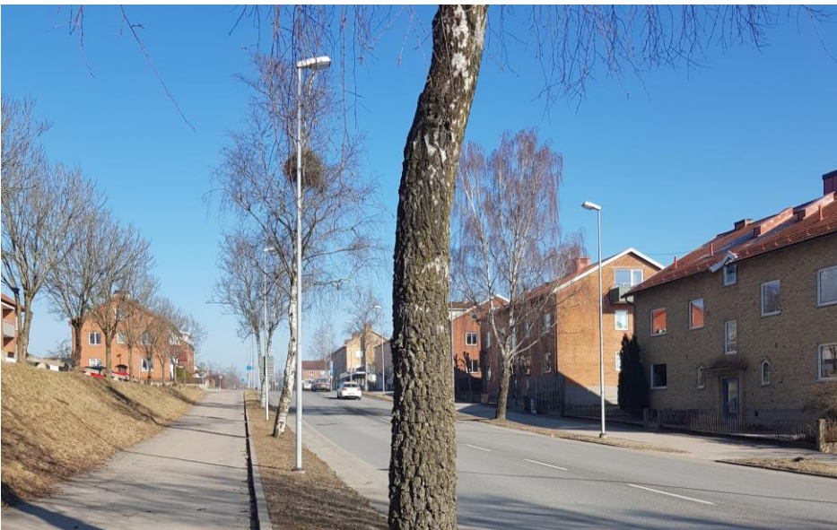
Figur 20. Götavägen, mellan Västbovägen och Fredsgatan (Foto Sweco).
