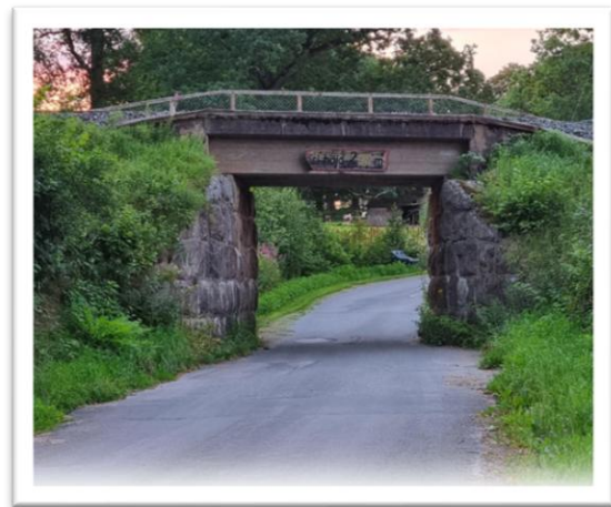
Figur 14, Bild på tunneln under järnvägen.
