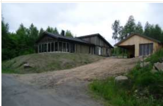
Från privat del av Bänkformarevägen. Bostadshuset på Mossle 16:61 ligger utanför gällande detaljplan idag, men blir genom planförslaget en del av nya kvarteret på delområde 3.
