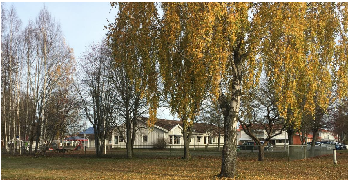
Nylunds förskola. Bilden är tagen från cykelvägen söder om förskolan.
