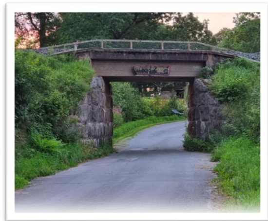
Figur 14, Bild på tunneln under järnvägen.
