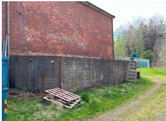
Figur 6. Muren efter invallning av oljecistern. Invallningen utnyttjades också för övningar. Då fanns oljecisternen i invallningen som var försedd med tak. Marken utanför invallningen är inte hårdgjord.
