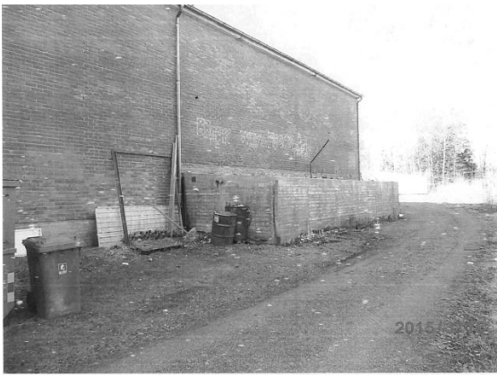
Figur 6. Muren efter invallning av oljecistern. Invallningen utnyttjades också för övningar. Då fanns oljecisternen i invallningen som var försedd med tak. Marken utanför invallningen är inte hårdgjord.
