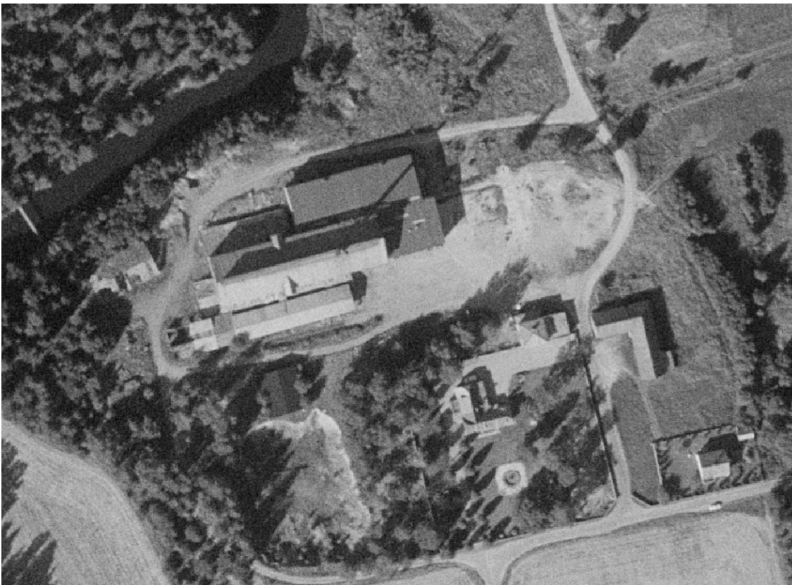
Figur 3. Flygbild 1972, norra delen av Tegelbruket har rivits, ny tegelbyggnad som finns idag. ©Lantmäteriet
