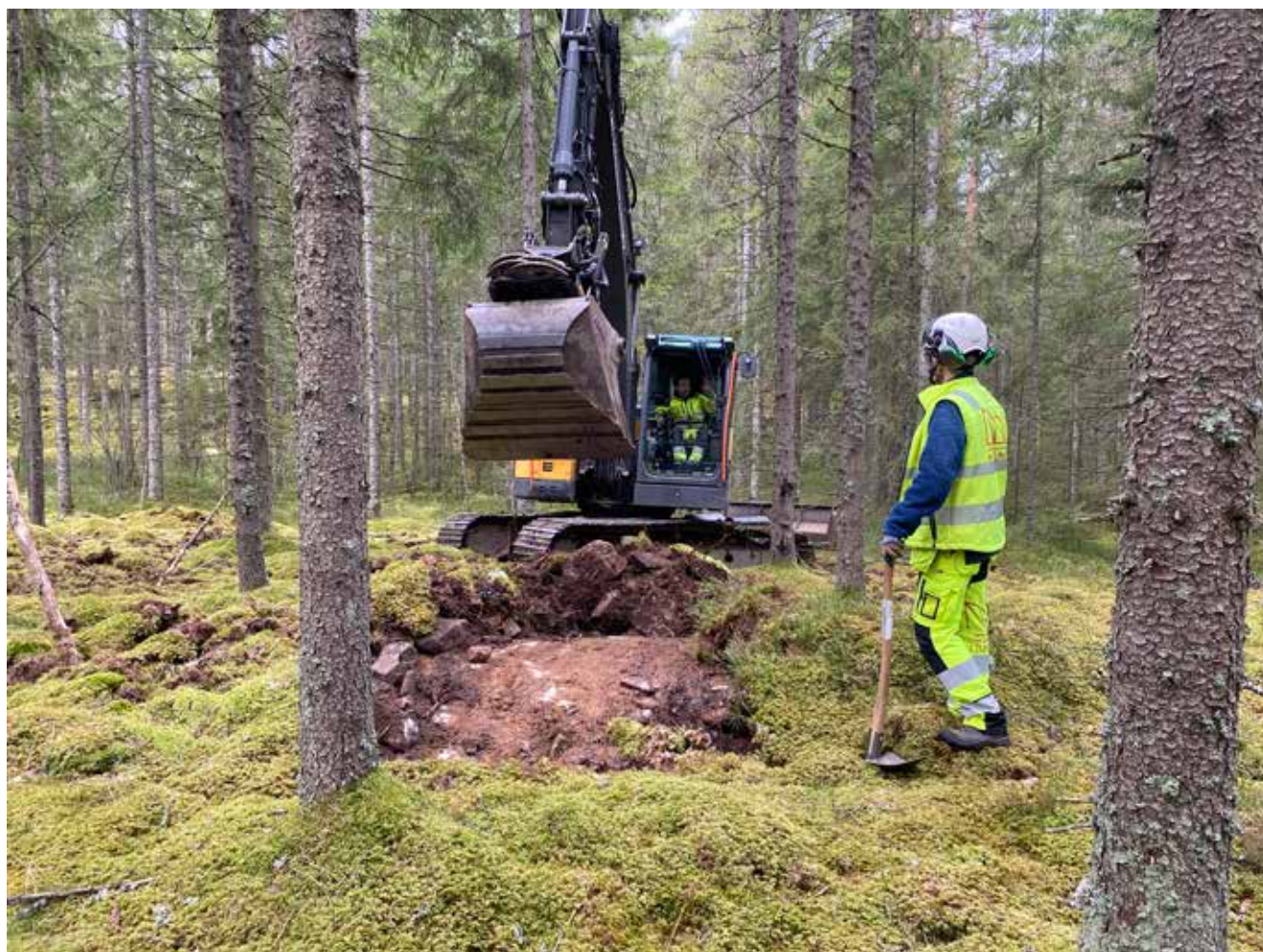
Figur 2. Schaktet genom Rr3 grävs. Foto från öster, Anna Ödeén.
