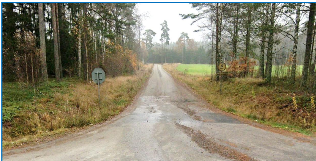
Bild 9. Befintlig enskild väg i anslutning till väg 151.
