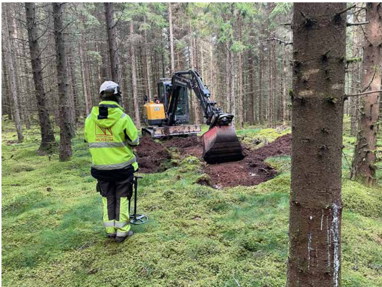
Figur 2. Schaktning pågår mellan stenarna.
