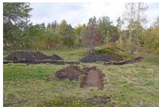
Figur 21 Mot schakt 290, 294 och 300. Foto taget mot NV.
