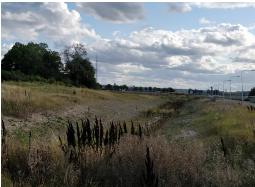
Figur 22. Exempel på brett svackdike med stor fördröjningsvolym per löpmeter.
