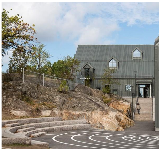
Exempel på genomtänkt placering av skolbyggnad med hänsyn till befintlig natur. Intressant gestaltning av plåtfasad som kan uppfattas vara träpanel på avstånd. Långbrodalsskolan i Älvsjö, ritad av NIRAS Arkitekter.
