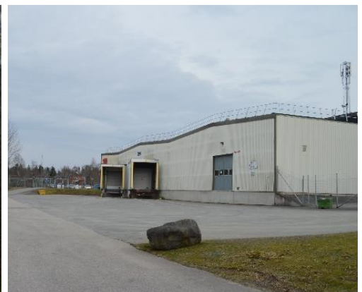
Industribebyggelse på fastigheten Drabanten 13, söder om planområdet.
