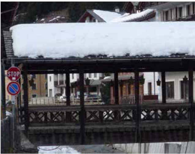
RESTAURERAT BROHUS I BORMIO. FOTO MICHAEL HÖÖG.
