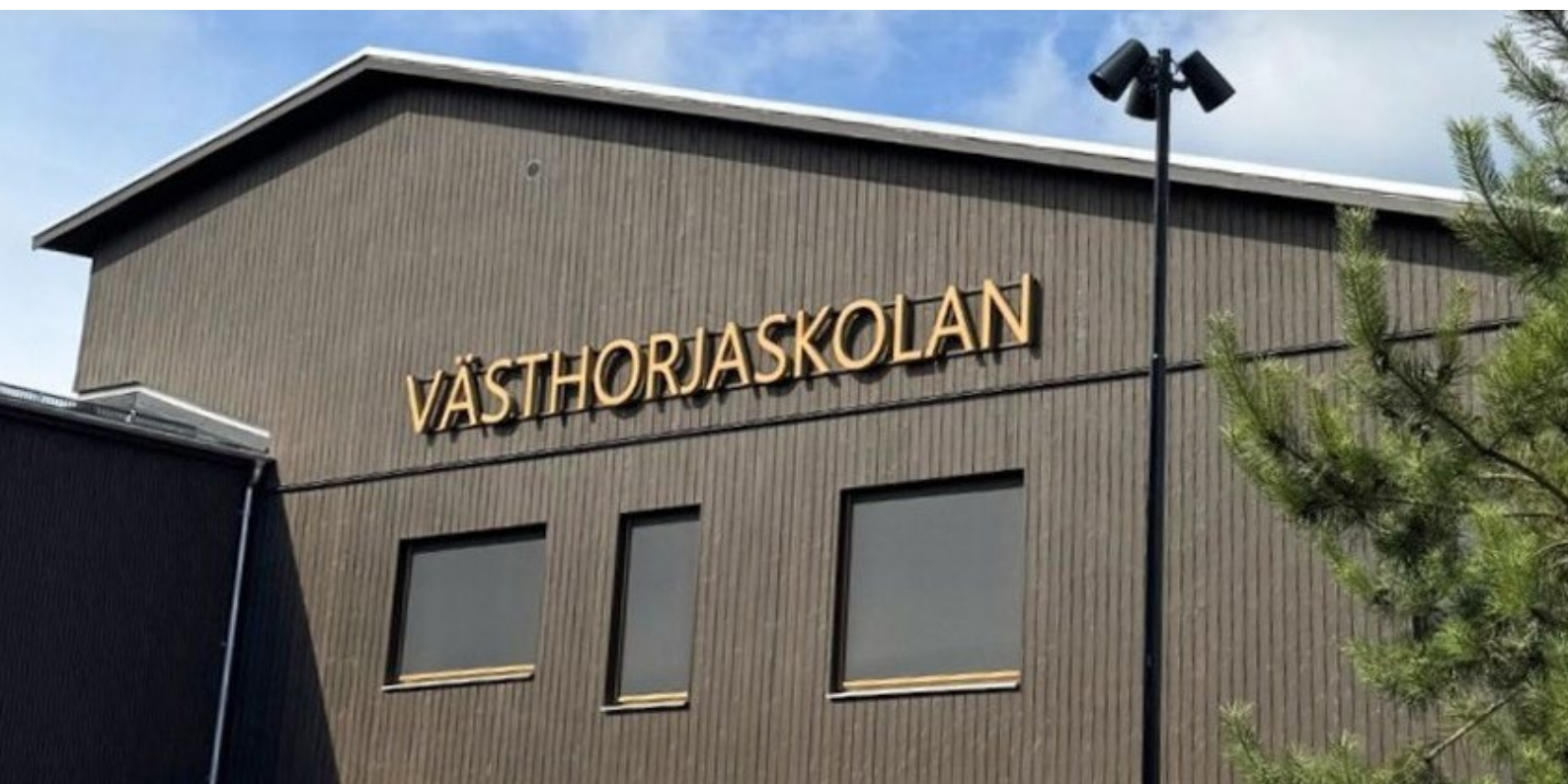
Västhörjaskolan, en nybyggd grundskola med moderna lokaler.
