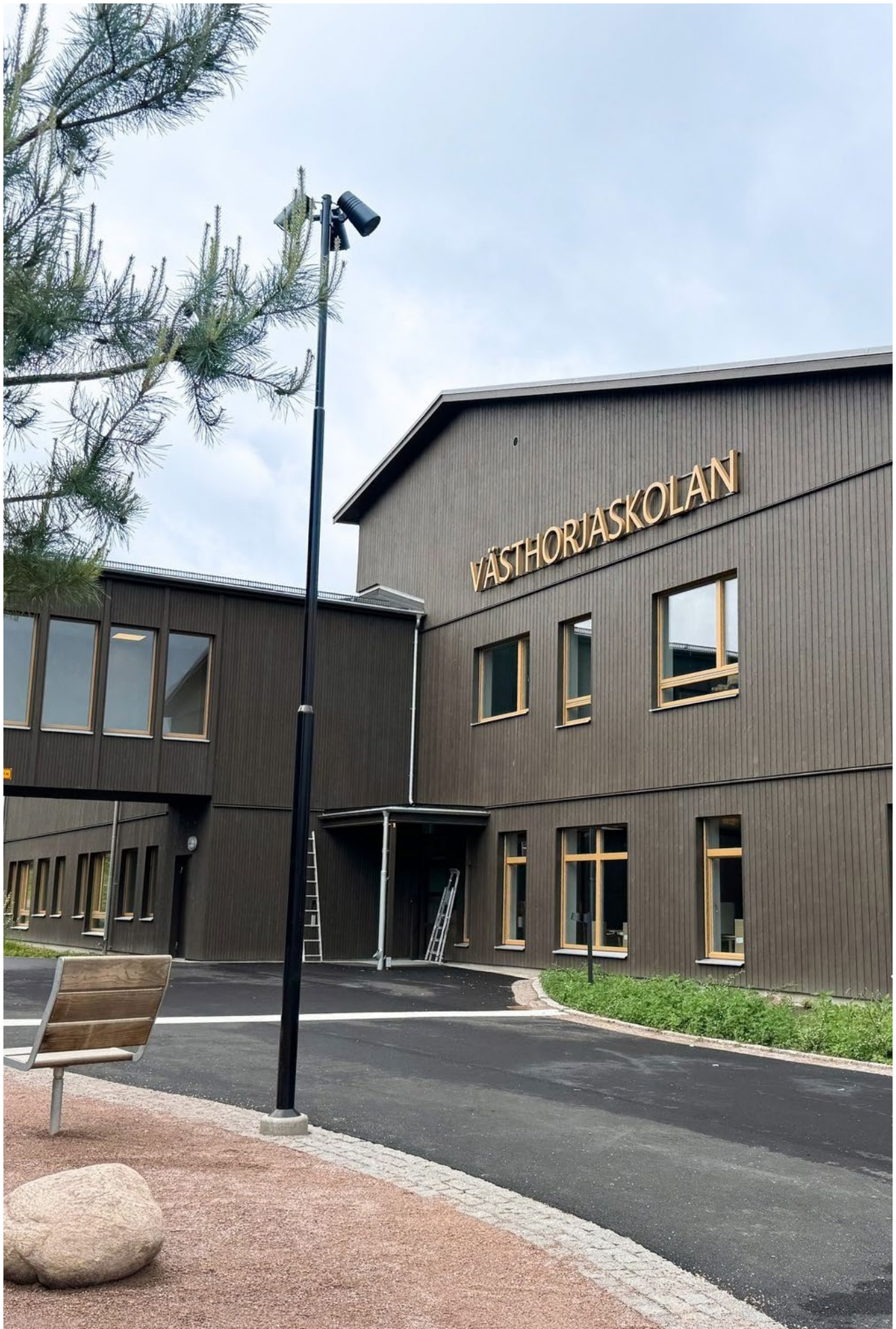
Framsidan av den nybyggda Västhörjaskolan, invigd i augusti 2025.
