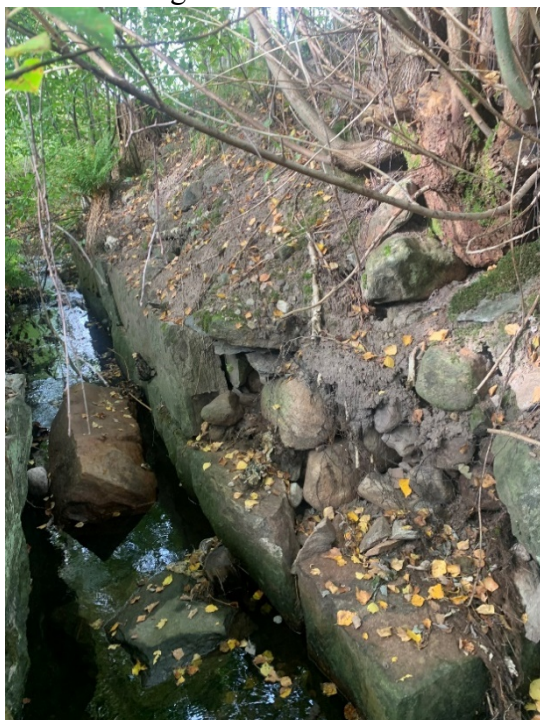
Figur 1 Delar av de gamla stenfundamenten för vägbron
